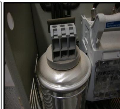
Medições da tensão durante 48h00, diretamente no capacitor do Filtro. Integração dos dados 2:2min. Quatro manobras des/lig. Energia reversa máxima de 689,5V (no desligamento do Filtro), durante 2ms.
